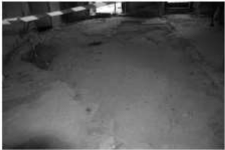
Imatge 23. Sostre planta baixa, crugia central, consolidació volta
