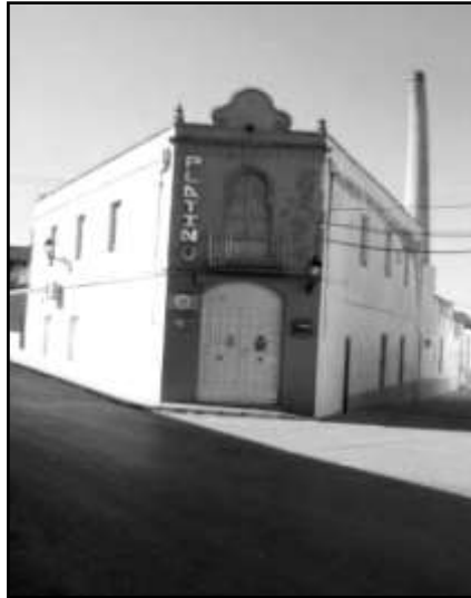
Figura 3. Chimenea con el fuste inclinado en el interior de la edificación. 2018.
