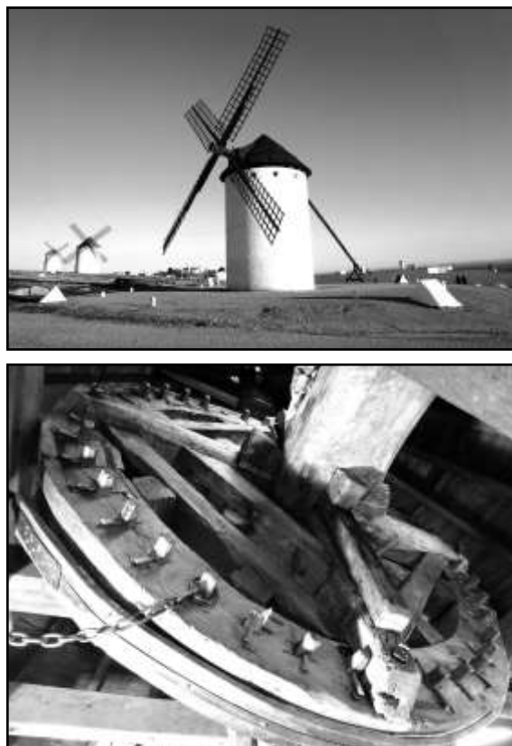
Figura 3 y 4. Molinos de viento en Campo de Criptana y rueda catalina del molino Sardinero.
