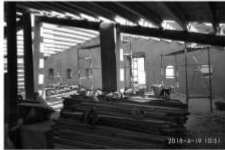
Imatge 24. Sostre planta mirador, substitució
