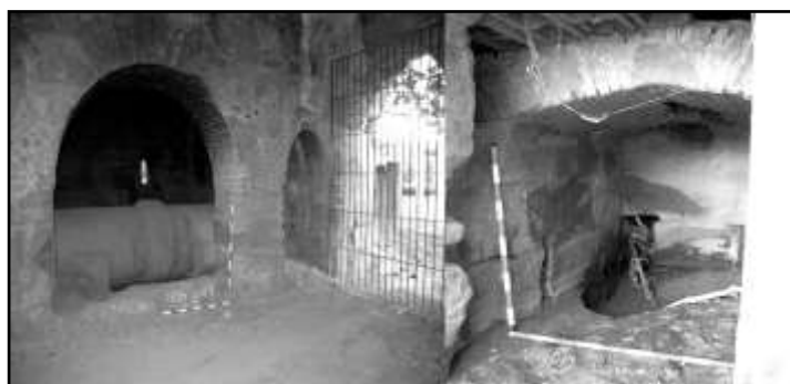
Figura 3. Tubería de hormigón que cruza el molino (imagen izquierda). Ubicación del rodezno bajo cúpula de cuarto de naranja de ladrillo (imagen derecha), (R. Córdoba y J. Varela).
