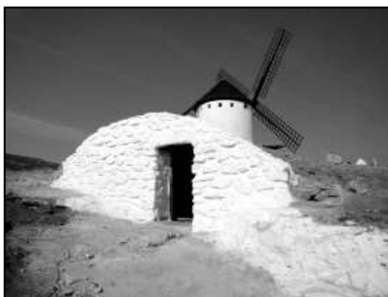
Figura 6. El silo del molino Infanto en 2011, después de su rehabilitación.
