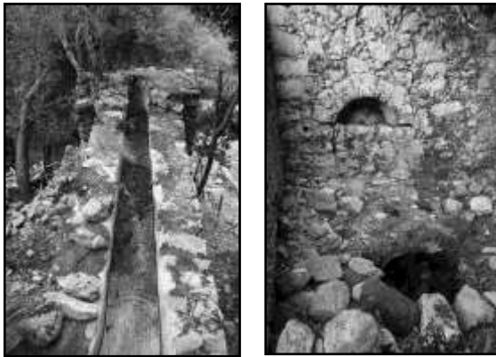
Figures 8 i 9. Estat actual de la síquia del molí i cub del torrent del Pixarell. Cacacu i desguàs del molí de la font de Turixant de Baix, al rierol del Pixarell.
