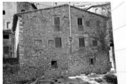
Imatge 12. Façana nord
