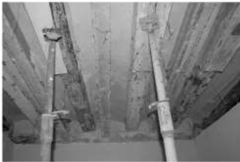
Imatge 15. Sostre planta primera, crugia nord
