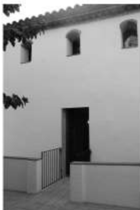
Imatge 18. Façana oest, detall
