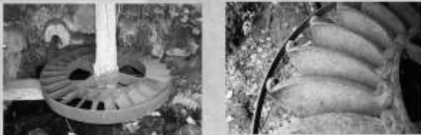
Los dos tipos de rodeznos más extendidos: de lámina (izquierda) y de cuchara (derecha)
