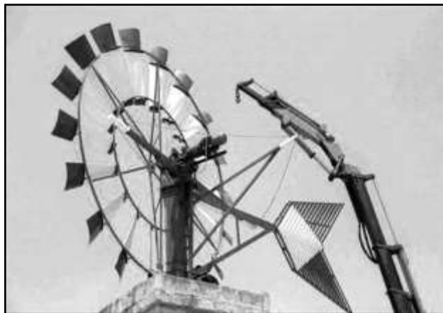
Figura 5. Detalle del montaje de un molino de extracción de agua (Campos).
