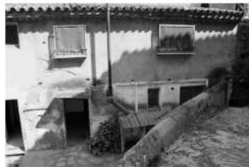
Imatge 10. Façana oest
