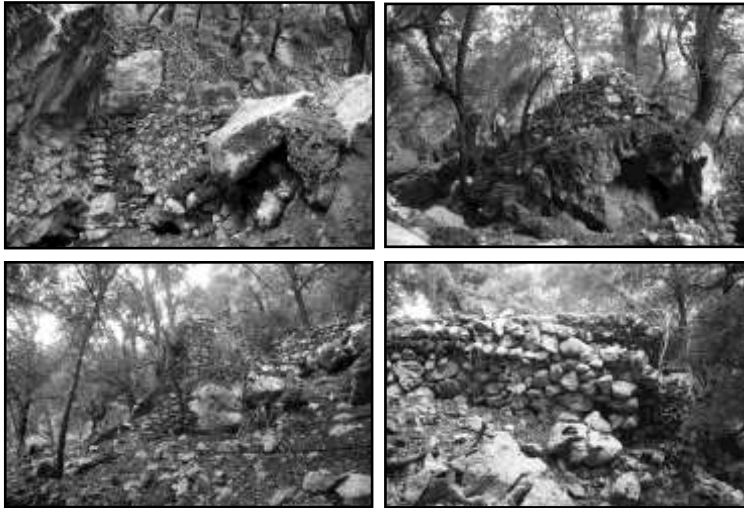
Figures 4-7. Traça del cub del Molí del Racó. Restes del cub del segon molí. Mur que suporta el cub del cinquè molí. Base del suport de la síquia del segon cub.
