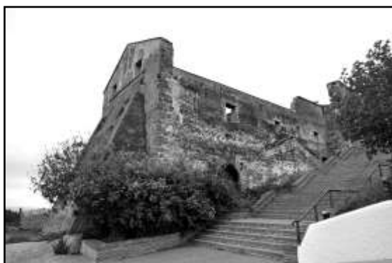
Figuras 3 y 4. Ingenio de Armengol o Ingenio de Maro. Estado actual del edificio, destacando el poderoso contrafuerte que lo sostiene por el lado que mira hacia el barranco (izq.). Ruinas de la Fábrica de las Mercedes o de San Joaquín, en Maro (dcha.).
