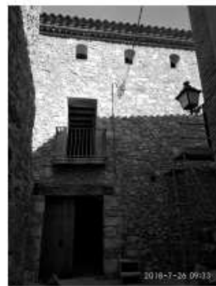
Imatge 20. Façana est, entrada
