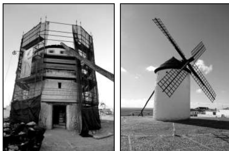
Figura 7. El molino Sardinero en 2014: durante los trabajos de rehabilitación, y al término de los mismos.
