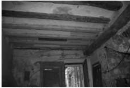
Imatge 21. Sostre planta baixa, crugia central, consolidació
